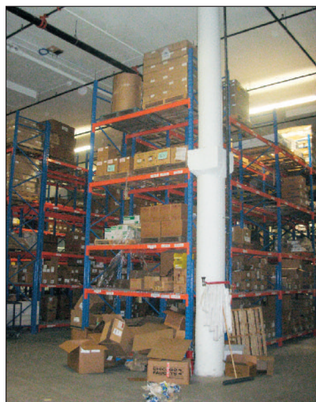
Sur la colonne, il est possible d'apercevoir où exactement le plancher de ciment a été enlevé à l'étage.
